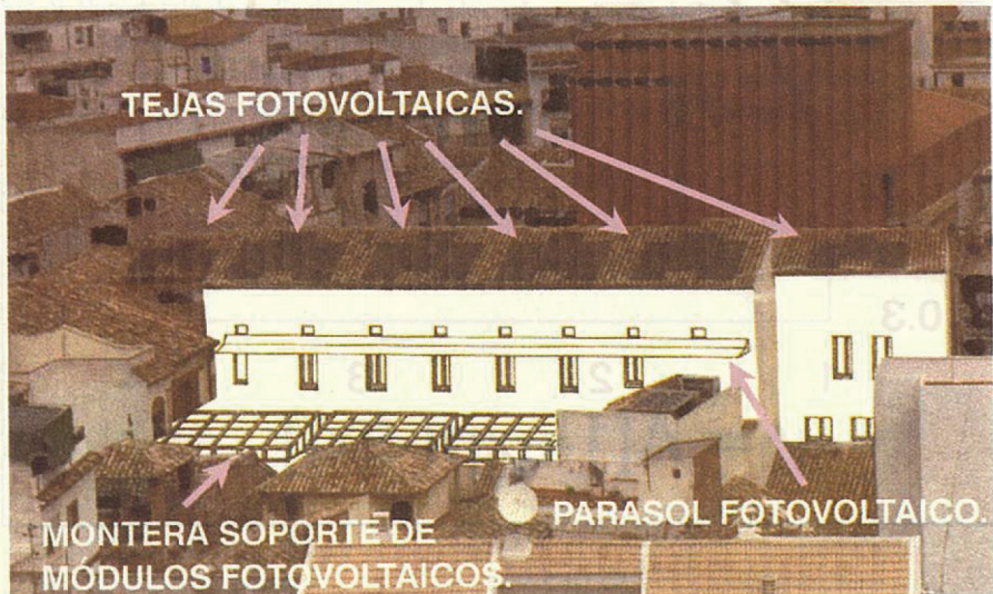
Fig. 12. Proyecto Iranzo. Aspecto de la integración arquitectónica del generador fotovoltaico.
