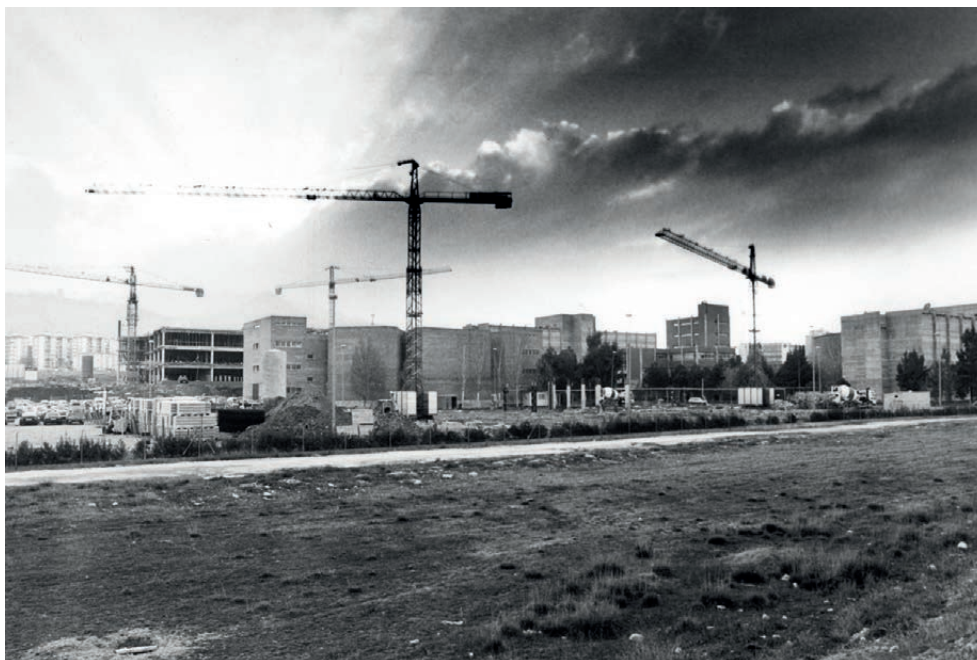
FIGURA 46— En primer término, inicio de las obras del edificio de la Facultad de Ciencias Sociales y Jurídicas, edificio D3 actualmente. Al fondo se observa como ya se habían levantado tres plantas del aula, edificio B-4 en el campus actual de la UJA. Fotografía: José M. Pedrosa. Fondo de la UJA.
