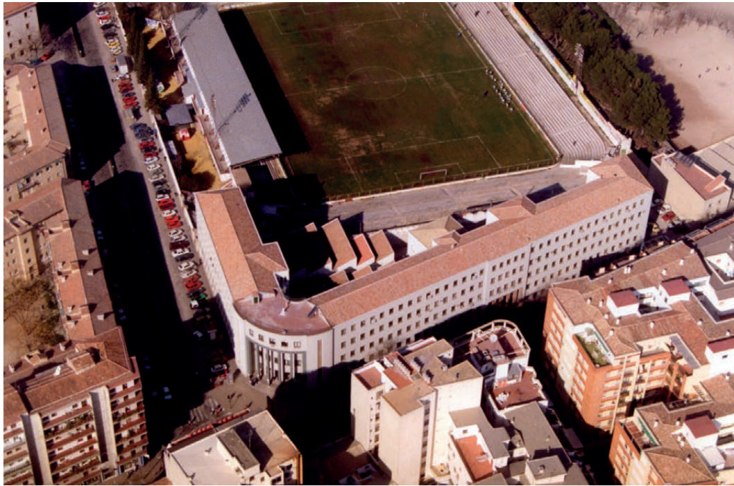
FIGURA 18— Fachadas anterior y posterior del edificio de la Escuela de Peritos y de la Escuela Pericial de Comercio. Fotografías cedidas por el archivo de la biblioteca de la Universidad de Jaén.
