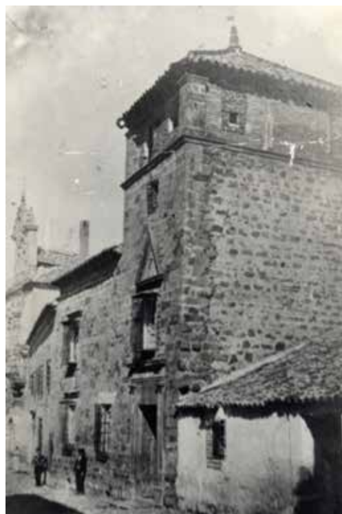
FIGURA 52— Casa convento Hospital de San Juan de Dios. Linares, 1896.
