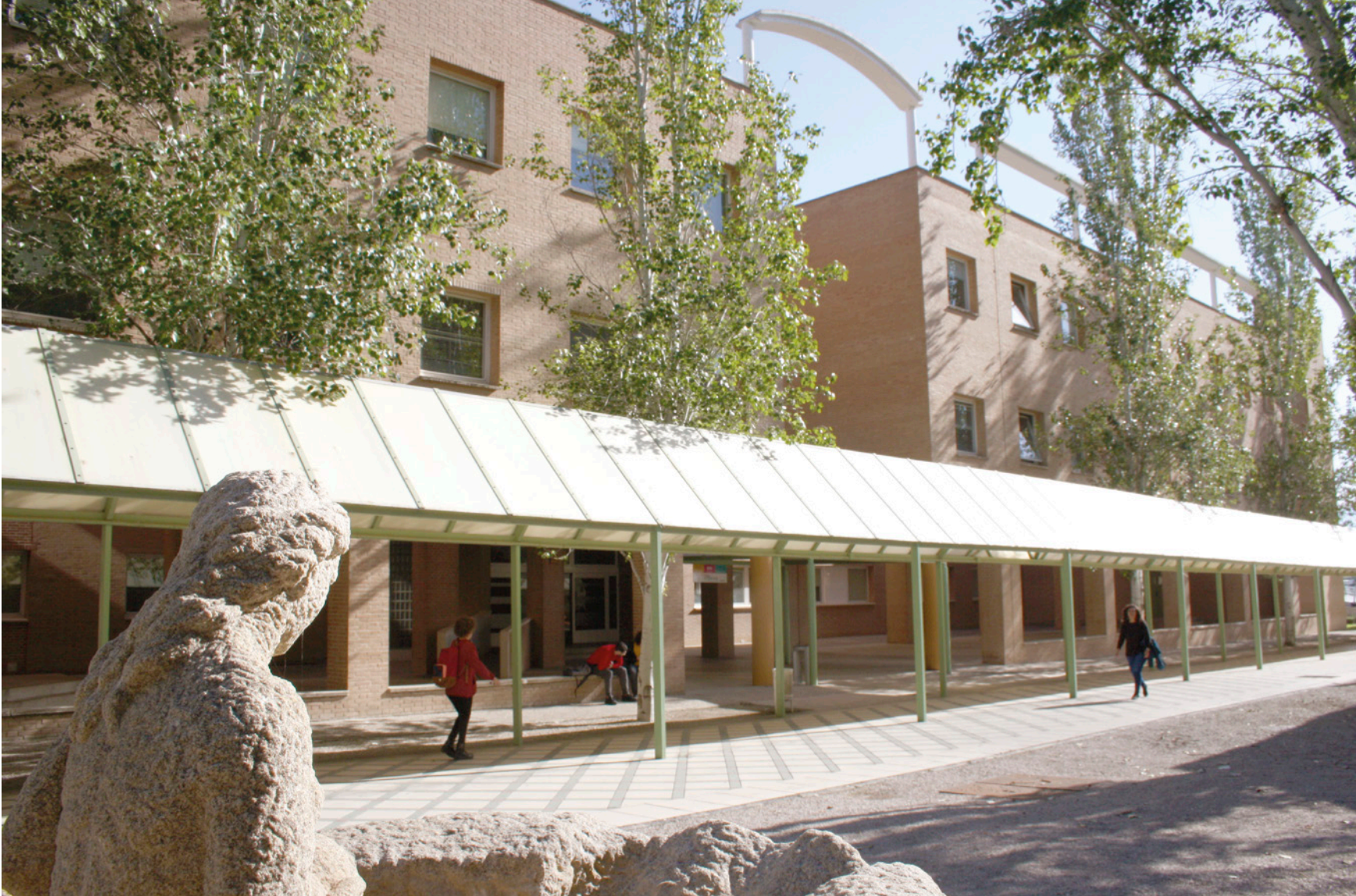
EDIFICIO DE CIENCIAS SOCIALES Y JURÍDICAS
