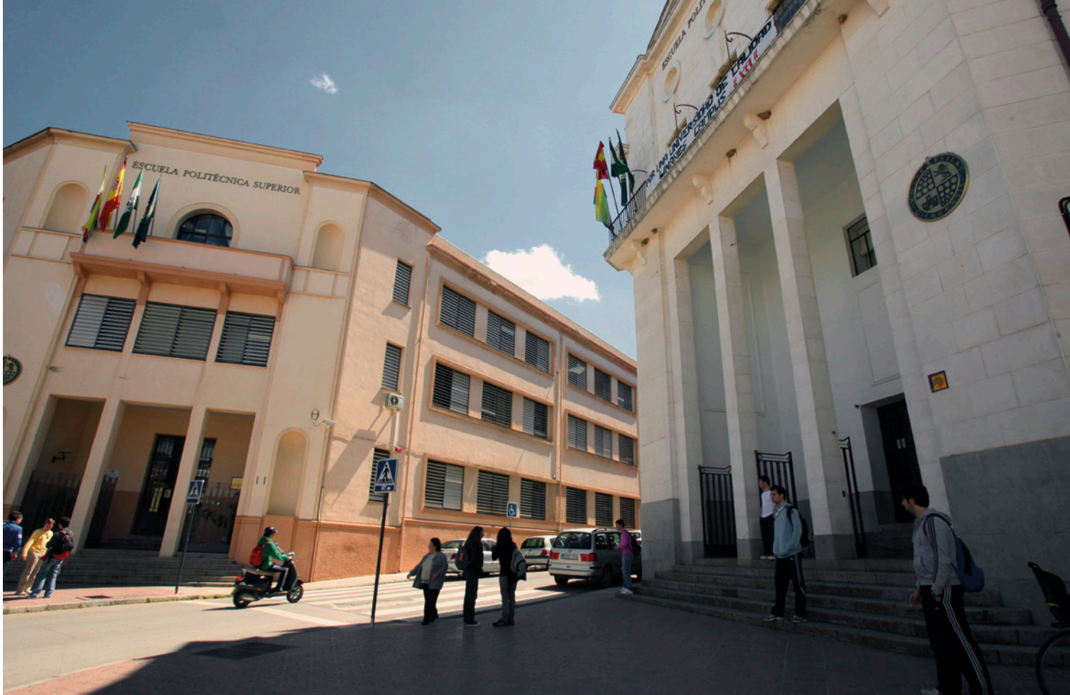
ANTIGUOS EDIFICIOS DE LA ESCUELA POLITÉCNICA SUPERIOR DE LINARES
