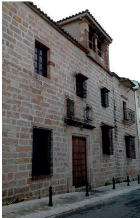
FIGURA 6— Palacio Zambrana de Linares.
